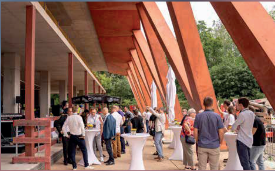
Gefeiert wurde unter den frisch gegossenen Kolonnaden aus rot eingefärbtem Beton.
